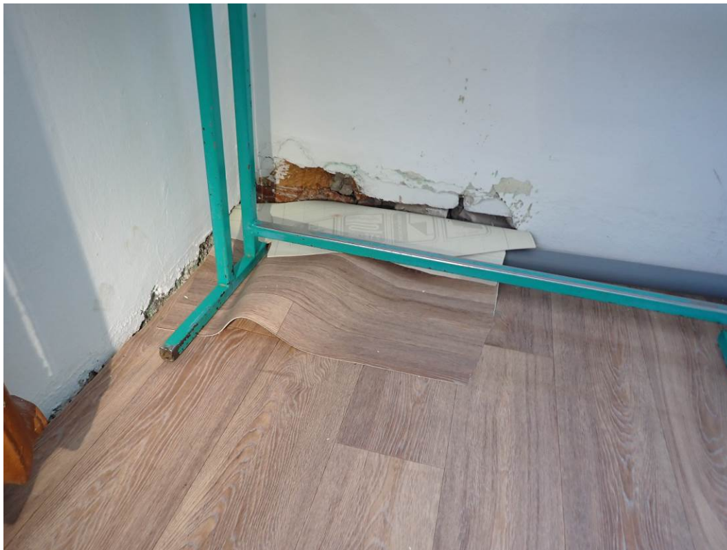
Фото 19. Повреждение кирпичной кладки внутренних стен здания.
