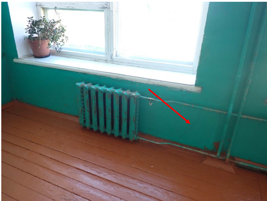
Фото 17. Наличие трещин в кирпичной кладке наружных стен здания.
