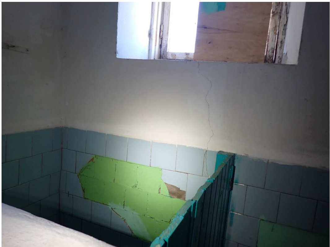
Фото 24. Наличие трещин в кирпичной кладке наружных стен.
