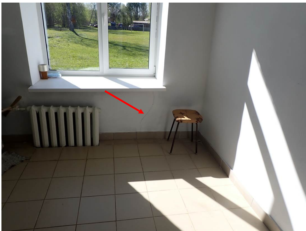
Фото 20. Наличие трещин в кирпичной кладке наружных стен здания.
